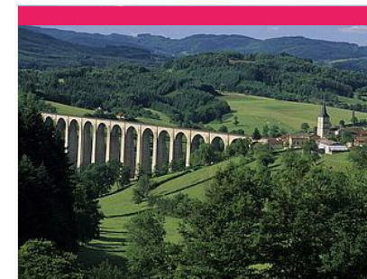
Viaduc de Mussy-sous-Dun
